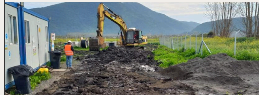
MEJORAMIENTO DE CAMINO - PARQUE FOTVOLTAICO EL CARDENAL - SAN VICENTE DE TAGUA TAGUA MANDANTE GEOM SPA
