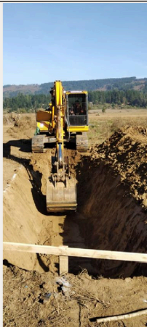
MOV DE TIERRAS, CONSTRUCCIÓN DE FOSO, OBRAS CIVILES Y CIERRE PERIMETRAL OBRA PARQUE FOTVOLTAICO CODORNIZ, COMUNA DE CUREPTO - MANDANTE GEOM SPA
