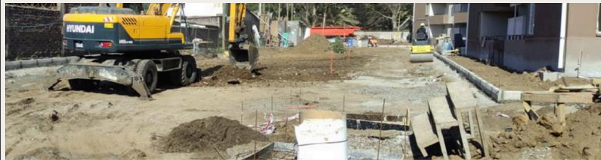
URBANIZACIÓN CONDOMINIO COSTA AZUL SAN SEBASTIÁN CARTAGENA - MANDANTE CONSTRUCTORA OVAL
