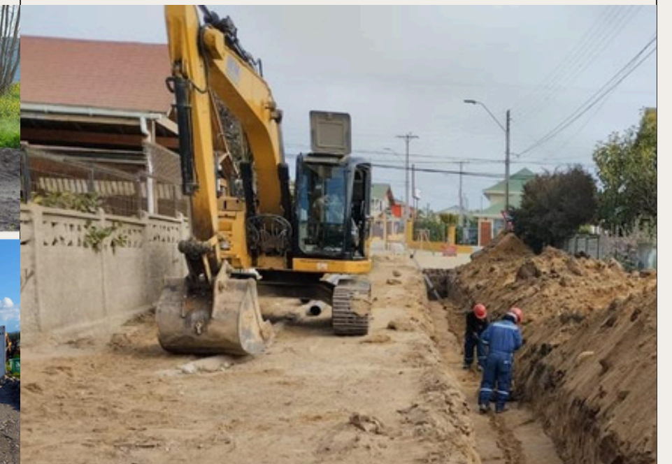
CONSTRUCCIÓN DE ALCANTARILLADOS INDEPENDENCIA, HORMAZABAL Y MARCHANT COMUNA DE EL QUISCO - MANDANTE CONSTRUCTORA GUILLERMO DÍAZ
