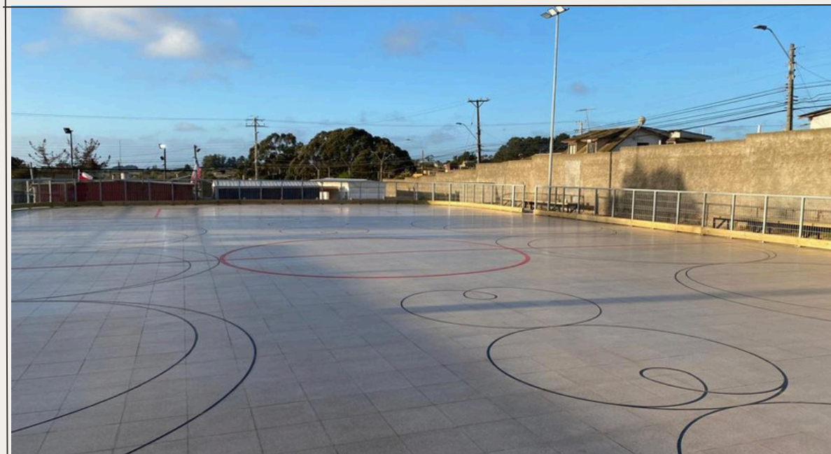
CONSTRUCCIÓN PISTA DE PATINAJE Y HOKEY PATINCOMUNA DEL QUISCO
